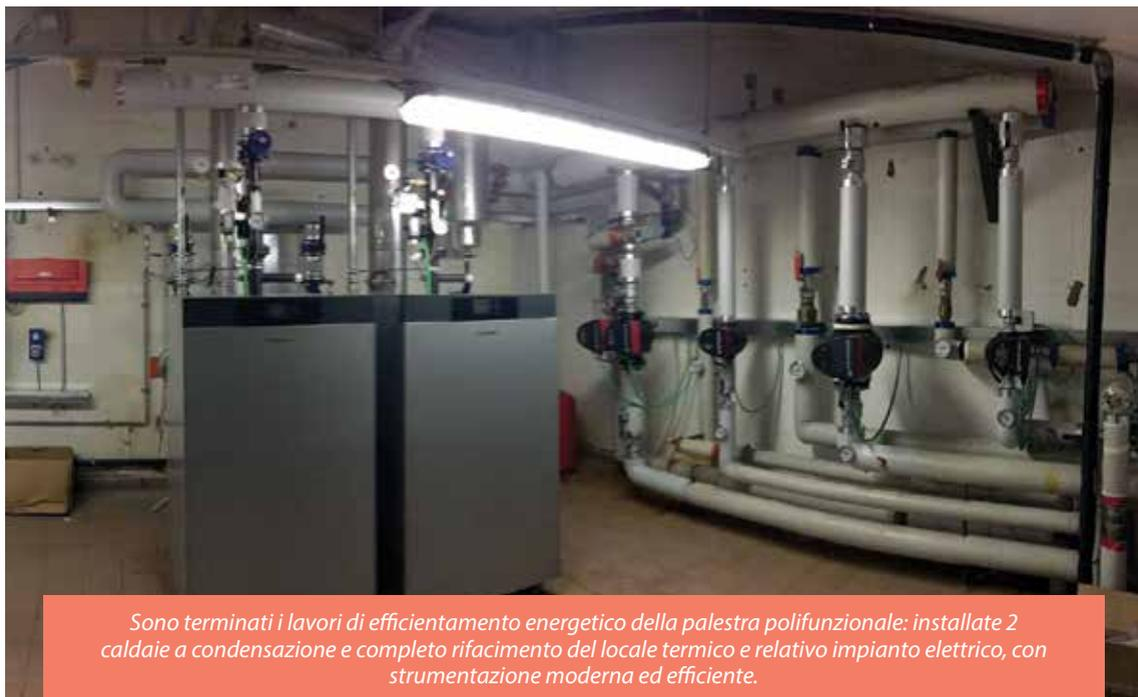
*Sono terminati i lavori di efficientamento energetico della palestra polifunzionale: installate 2 caldaie a condensazione e completo rifacimento del locale termico e relativo impianto elettrico, con strumentazione moderna ed efficiente.*
