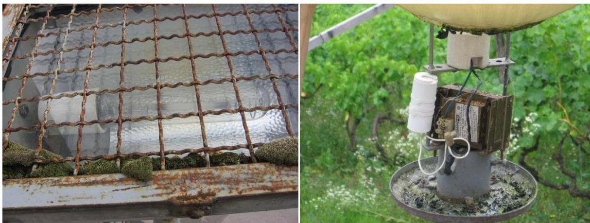
Fig. 39 – Situazioni critiche individuate per lo stato di protezione dei corpi illuminanti
