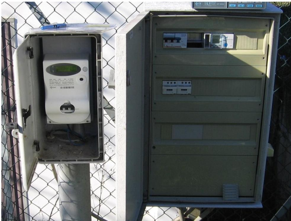
Fig. 23 – Il quadro dell'impianto di illuminazione pubblica installato presso il centro commerciale
