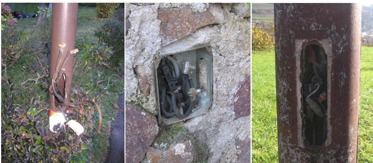
Fig. 38 – Situazioni critiche individuate per lo stato di conservazione dei collegamenti elettrici
