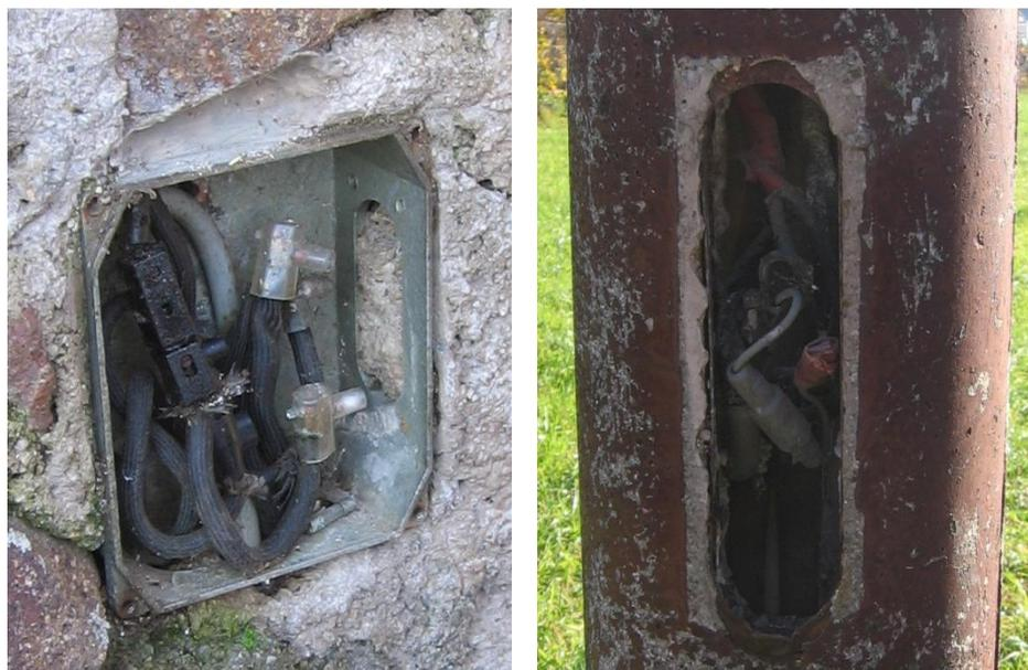
Fig. 35 – Particolare di derivazioni per l'alimentazione di punti luce
