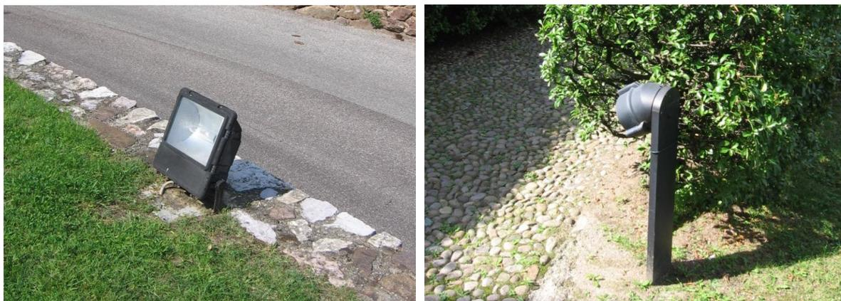
Fig. 55 – Tipologie di corpi illuminanti installati in prossimità del municipio: fari ai vapori di mercurio della potenza di 400 W (a sinistra) e corpi illuminanti da arredo ai vapori di mercurio della potenza di 70 W (a destra).
