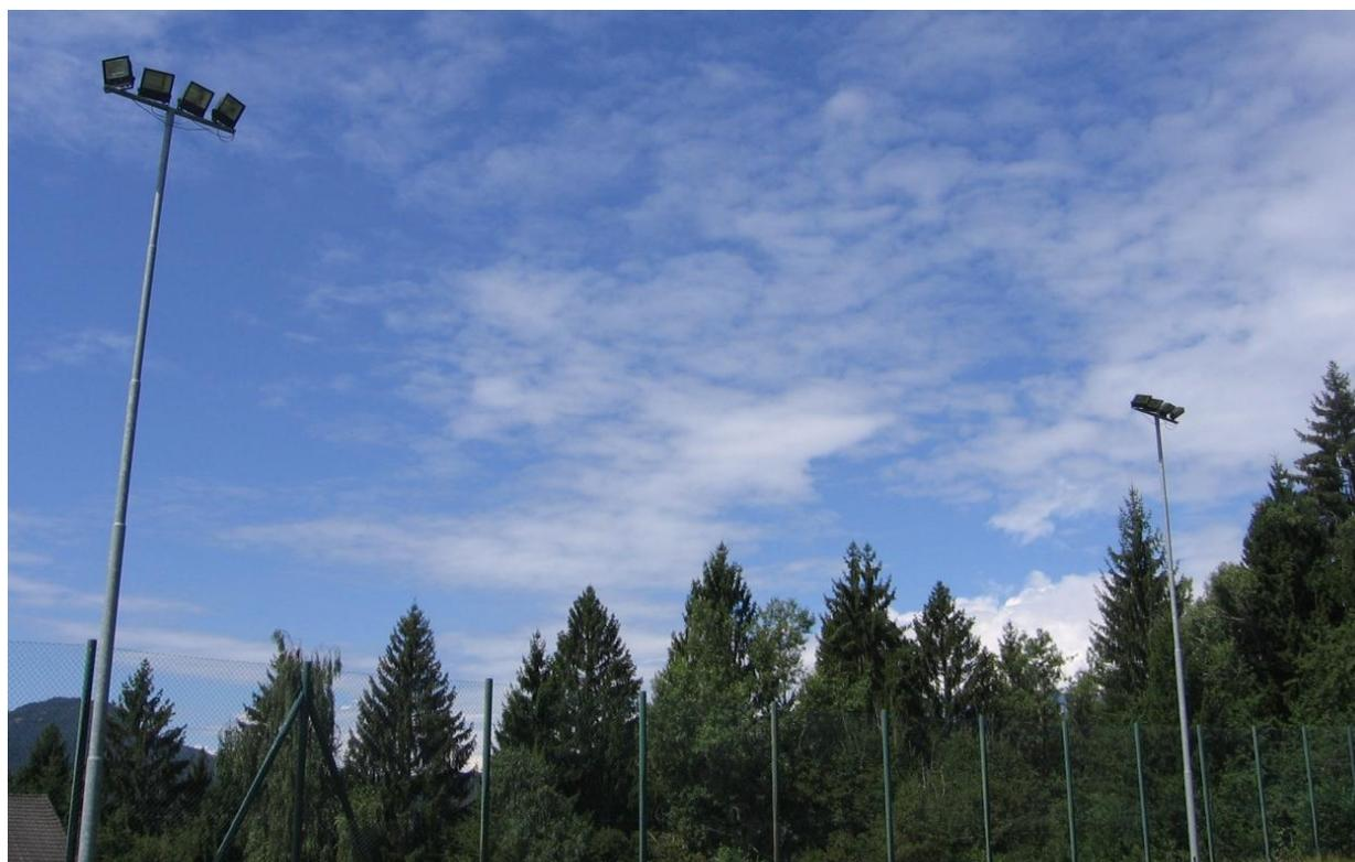
Fig. 59 – Punti luce con 4 fari agli ioduri metallici di potenza pari a 400 W, installati al campo sportivo di S.Agnese.
