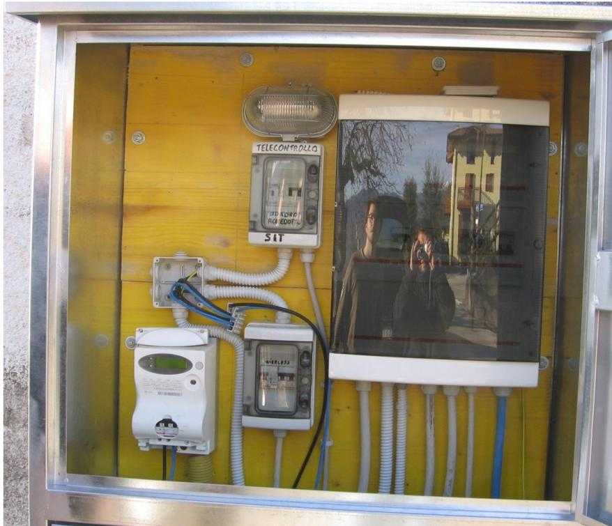
Fig. 13 – Il quadro installato sulla cabina di trasformazione a Mazzanigo
