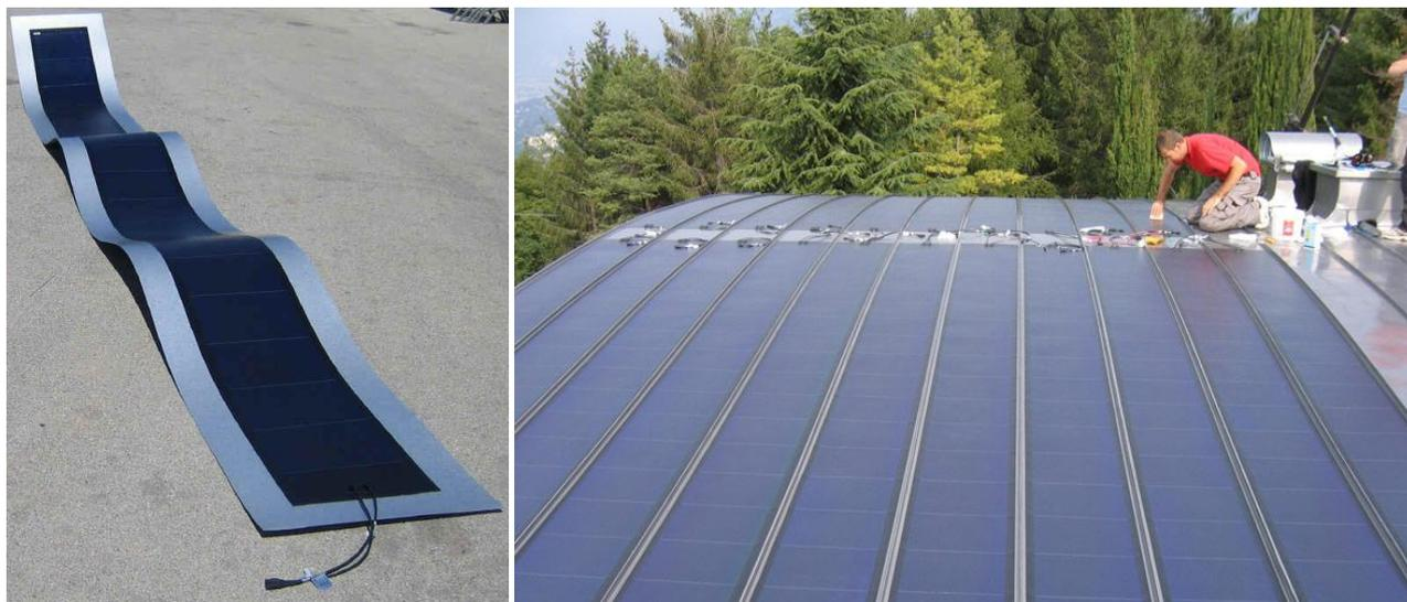
*Fig.17 – Esempi di moduli fotovoltaici a film sottile. I moduli si applicano alla copertura per mezzo di materiali adesivi oppure vengono installati su profilati metallici.*
