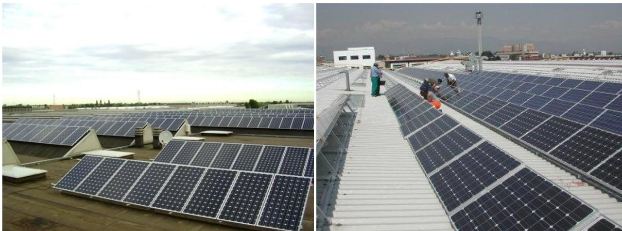
*Fig. 18 - Esempi di moduli in silicio monocristallino installati sulla copertura. In genere questa tipologia di moduli viene montata su strutture di metallo con un angolo di inclinazione ottimale.*
