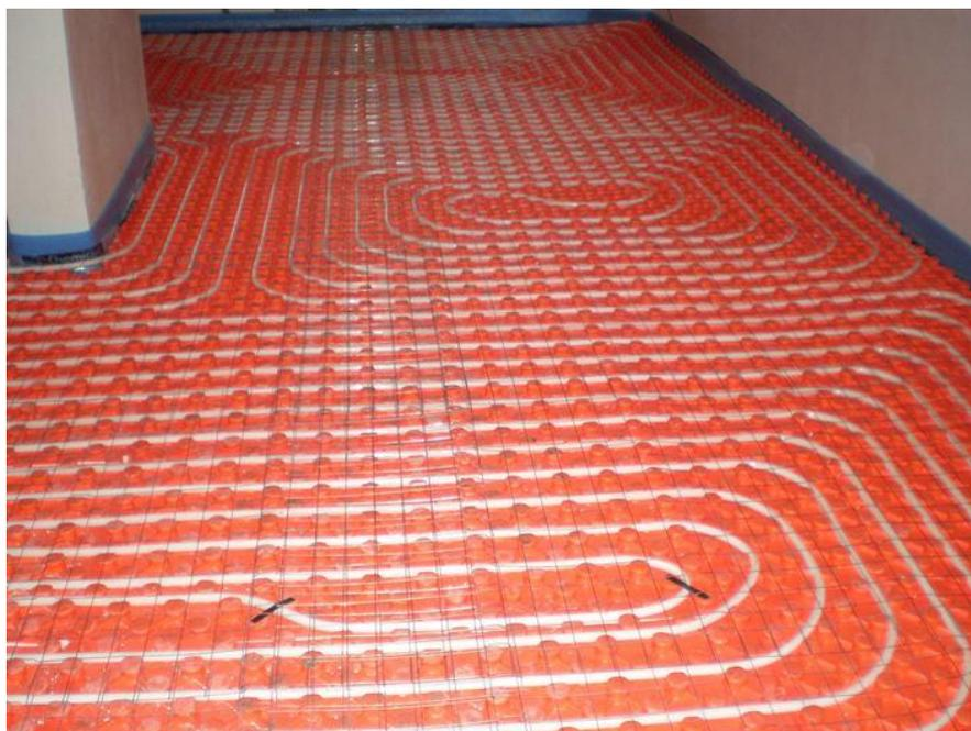
Fig. 11 – Esempio di posa di pannelli radianti a pavimento.
