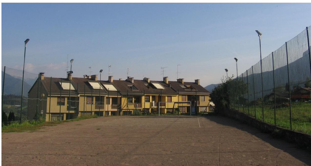
Fig. 62 – Punti luce con installato 1 faro agli ioduri metallici di potenza pari a 400 W ciascuno, presenti al campo sportivo di Torchio.
