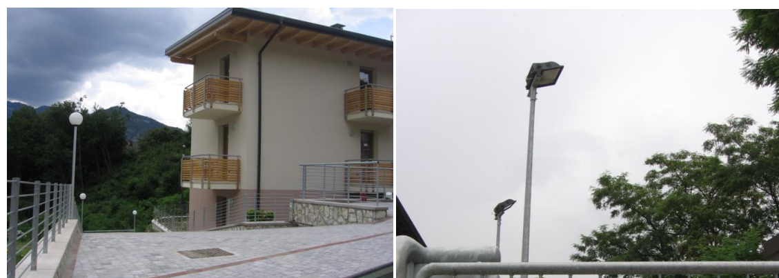
Fig. 71 – Punti luce privati a Bampi e fari presso la bocciofila di Civezzano
