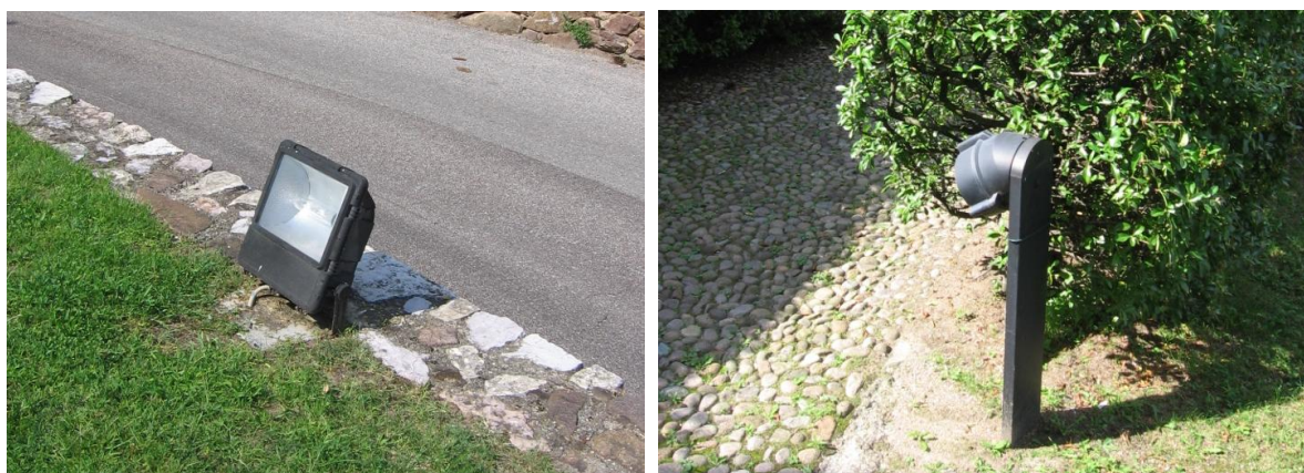
Fig. 55 – Tipologie di corpi illuminanti installati in prossimità del municipio: fari ai vapori di mercurio della potenza di 400 W (a sinistra) e corpi illuminanti da arredo ai vapori di mercurio della potenza di 70 W (a destra).
