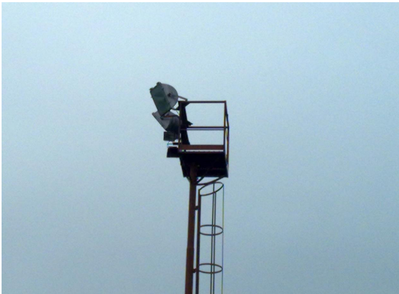
Fig. 57 – Tipologie di corpi illuminanti utilizzati per l'illuminazione del campo sportivo: fari agli ioduri metallici di potenza pari a 400 W e di potenza pari a 2.000 W.
