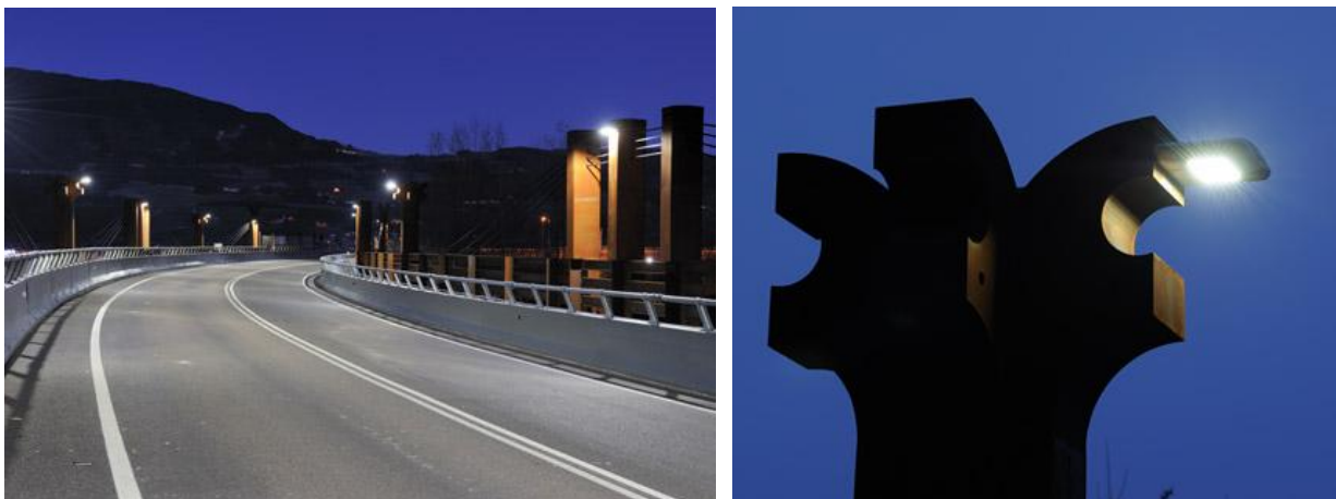
Fig. 6 - Fotografia del ponte Ululone in provincia di Trento nei pressi di Zambana
