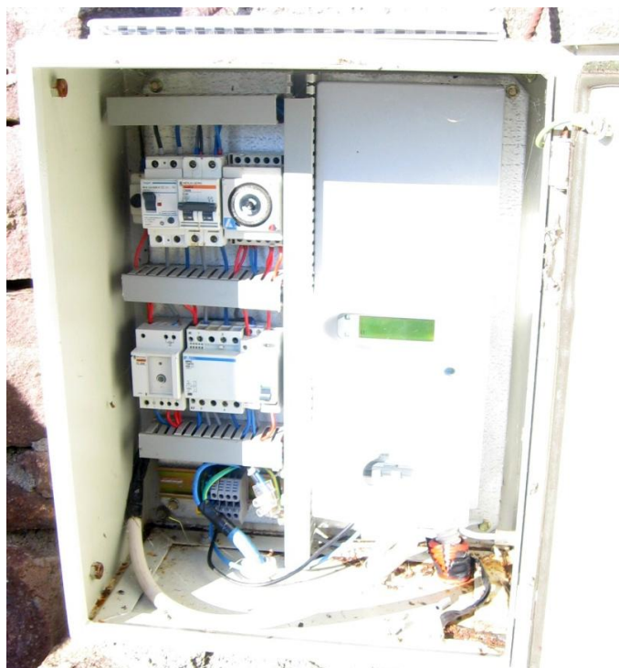
Fig. 9 – Il quadro a servizio della frazione Canova
