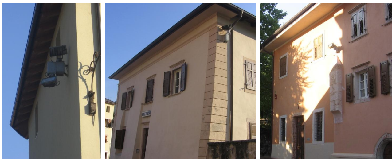
Fig. 53 – Fari ai vapori di sodio della potenza di 250 W montati su 3 diversi edifici presenti nelle vicinanze della chiesa.
