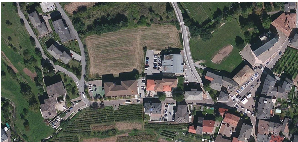
Immagine 01 Orto foto in cui si evidenzia l'area di intervento
